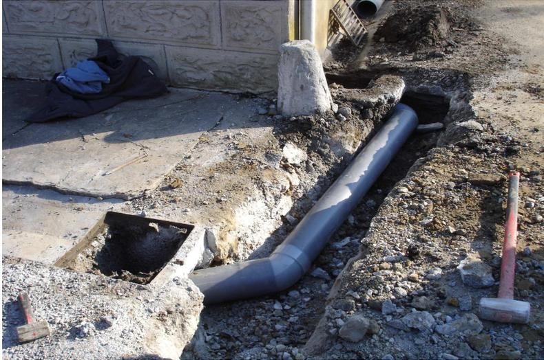
**PHOTO N° 4 : captation des eaux pluviales du fossé droit du chemin des Artigots**
