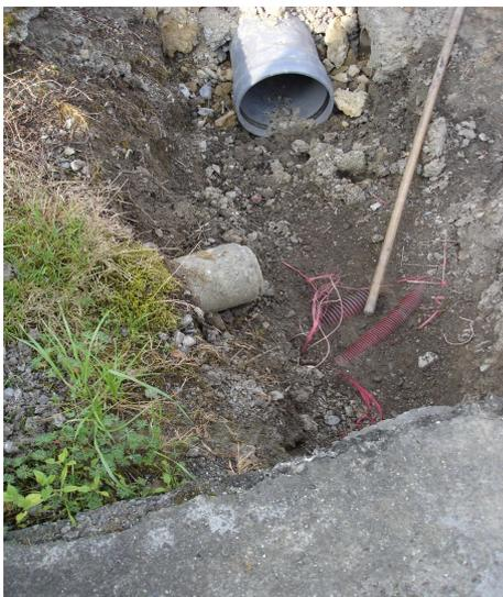
**PHOTO N° 5 : raccordement de la nouvelle tuyauterie PVC venant du fossé droit des Artigots à l'ancienne canalisation en pierre**
