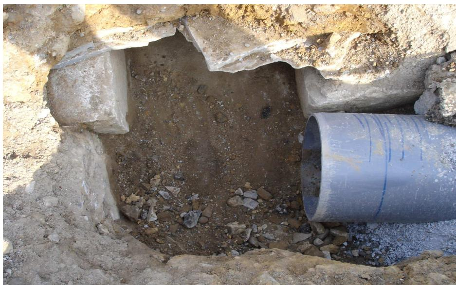
**PHOTO N° 6 : ancienne canalisation en pierre débouchant sous le pont**
