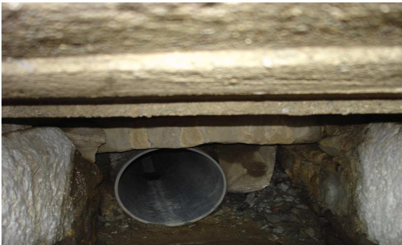
**PHOTO N° 3 : captation des eaux pluviales du côté gauche du chemin des Artigots**
